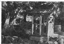
屋敷稲荷(高平)右が本殿、左がおかり屋 (関口正巳撮影)
