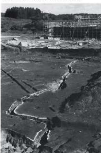
(12) 4 HSD01完掘状態
