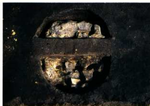
(4) 1 HRP01粘土堆積状態
