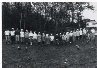
第1号住居跡調査前状況(東→)
