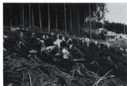
中区 抜根作業 SW→
