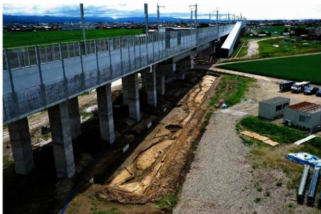
II-1区全景（北から）
