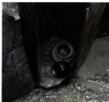
● 準構造造船をリサイクルして井戸枠に使っています 井戸の深さ3.2m、船材長さ2.1m
