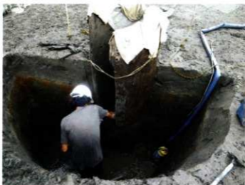
● 準構造造船をリサイクルして井戸枠に使っています 井戸の深さ3.2m、船材長さ2.1m
