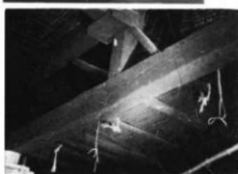
に達している。その下ダイコク相当柱の梁間断面は同図の右で、ヌキと脚元とに短いスジカイが取りつけてあるが、これは後補である。また桁行方向の断面はその左図で実地に見たのは、この一例に止った。
