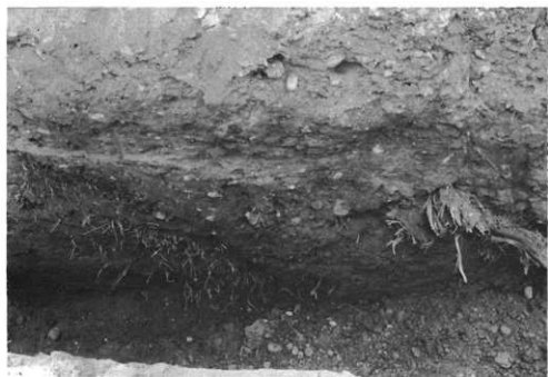
Aトレンチ法面の竹根（南から）
