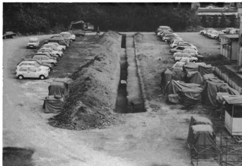
Bトレンチ完掘状況（西から）
