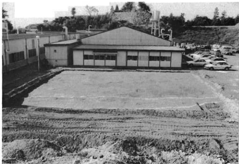
Aトレンチ拡張区全体写真（東から）
