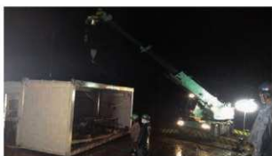
流出プレハブの夜間撤去作業
