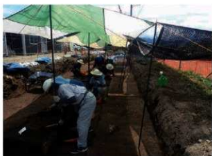
現場作業の暑熱対策
