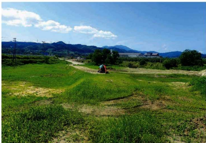
A区全景（北東より）
