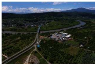
第3図 西部山地と現千曲川氾濫原 栗林地蔵上空から北西方向を撮影した。写真中央が上今井橋、 右手奥が斑尾山（2019年6月25日ドローンにて撮影）
