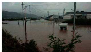
2019（令和元）年台風19号による千曲川の氾濫被害
