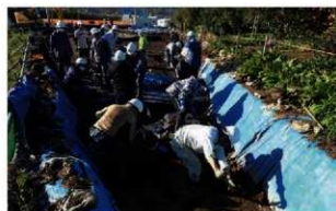
作業員による洪水上砂の除去作業
