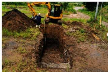
A区6トレンチ西南壁 土層断面 (北東より)
