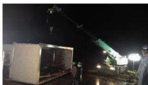
流出プレハブの夜間撤去作業
