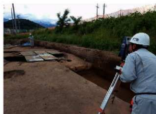
測量業者による現場測量
