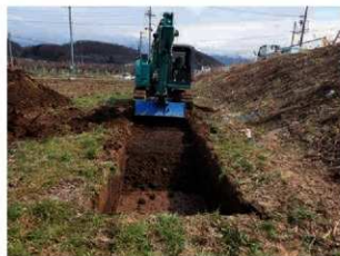
重機による表土掘削作業
