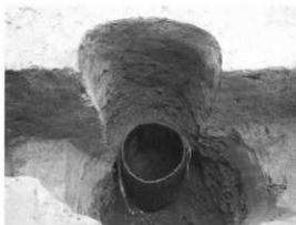
2. SE5完掘状況 (南東から)
