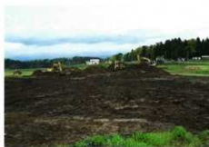
耕作土除去作業
