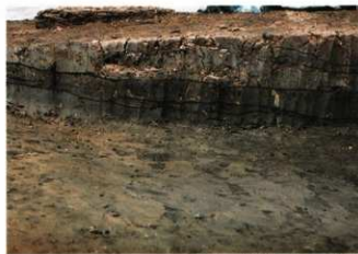
下層の土層断面 (C1-6付近)
