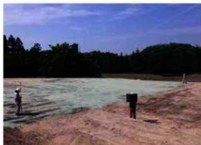
保護盛土完成 (NE→)
