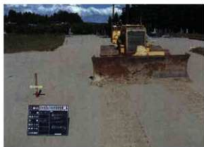
保護盛土(砂)敷き均し作業状況 (W→)
