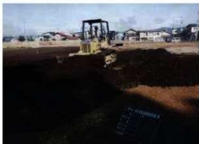
保護盛土（黒土）敷き均し作業状況（SE→）
