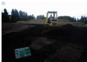
保護盛土（黒土）敷き均し作業状況 (E→)
