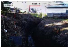
浚渫工No.0+200m地点完成 (W→)
