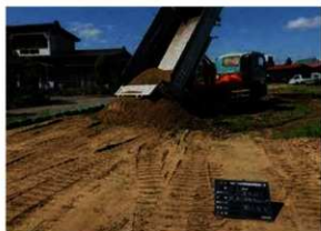
保護盛土(砂)搬入状況 (S→)
