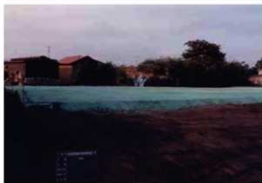
保護盛土完成 (S→)
