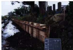
板柵設置完了状況 (E→)
