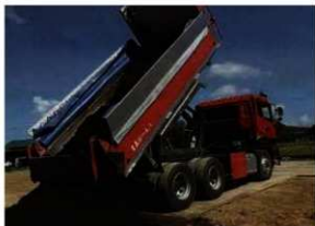
保護盛土（黒土）搬入状況（W→）
