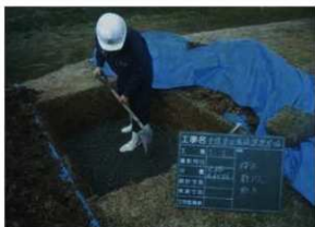
史跡名称板砕石敷き均し作業状況 (S→)
