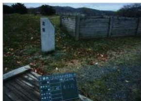
案内板2(北館)着工前(W→)
