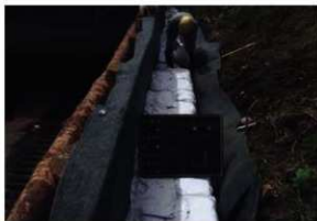
板柵工・土のう積作業状況 (ENE→)
