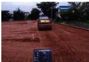
保護盛土(粘性土)転圧作業状況 (S→)
