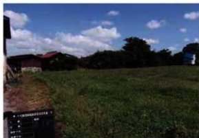
保護盛土着工前 (S→)
