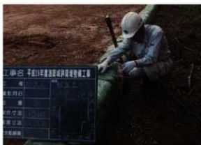
法面工・植生土の厚さ確認作業状況
