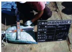
法面工・植生土のう検品作業状況
