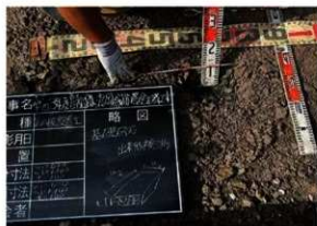
案内板基礎砕石測定状況 (N→)
