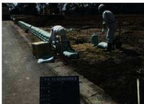
法面工・植生土のう積作業状況（N→）
