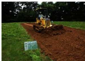
保護盛土(粘性土)敷き均し作業状況 (NE→)
