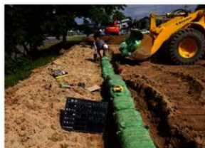
法面工・植生土のう積作業状況 (E→)
