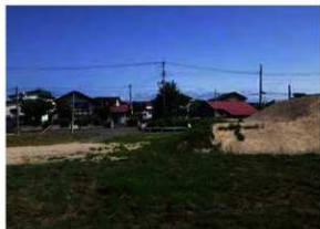
保護盛土着工前 (S→)
