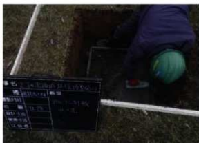
園路表示板（北館2）均しコンクリート打設作業状況
