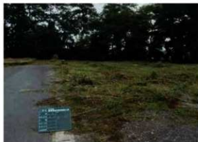
保護盛土着工前 (N→)
