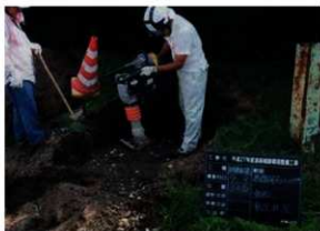
誘導標識（片面1）砕石敷き均し作業状況（N→）
