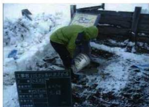
案内板2(北館)モルタル充填作業状況(W→)
