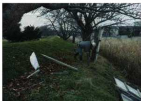
既設名称板撤去作業状況 (E→)
