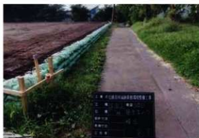
法面工・植生土のう積完成 (S→)
