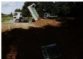
保護盛土(粘性土)搬入状況 (W→)
