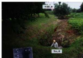
浚渫工No.0地点施工前 (S→)
