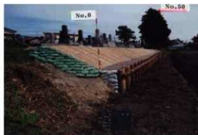
法面工・板柵工完成 (SW→)
