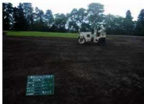
保護盛土（黒土）転圧作業状況 (N→)
