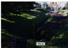
浚渫工No.0地点完成 (S→)
