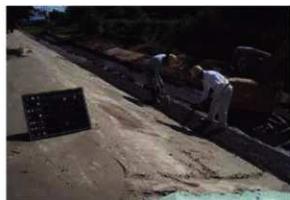
板柵工・砕石ズリ埋戻し作業状況 (NW→)
