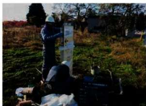
誘導標識（片面2）設置作業状況（NE→）
