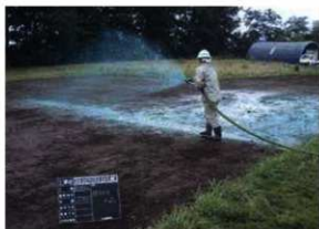
種子散布作業状況 (NE→)
