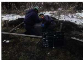
園路表示板（内館）設置作業状況（E→）
