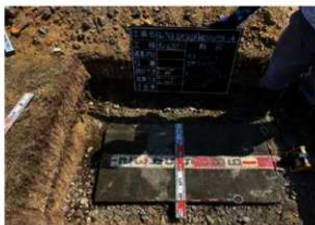
案内板均しコンクリート測定状況 (N→)
