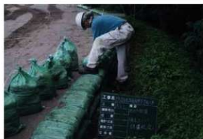
法面工・植生土のう積作業状況 (W→)
