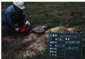
付帯工・伐採幹切断作業状況 (E→)
