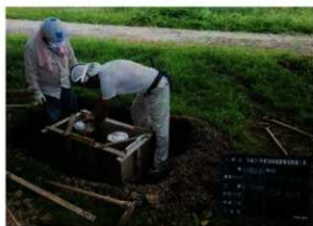
誘導標識（両面）基礎型枠設置作業状況（N→）
