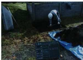
案内板2(北館)掘削作業状況(W→)
