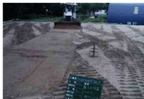
保護盛土(砂)敷き均し作業状況 (E→)
