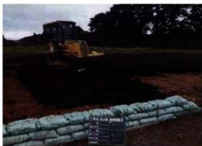
保護盛土 (黒土) 敷き均し作業状況 (W→)
