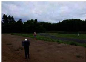
保護盛土着工前 (NE→)
