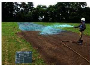
種子散布作業状況 (NE→)
