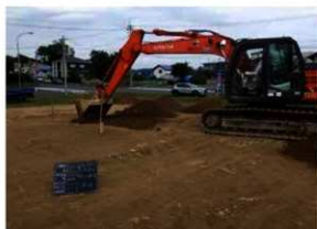
保護盛土(粘性土)敷き均し作業状況 (S→)
