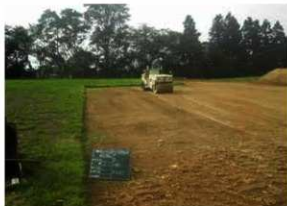
保護盛土（粘性土）転圧作業状況 (N→)
