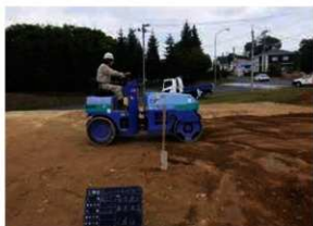
保護盛土(粘性土)転圧作業状況 (E→)
