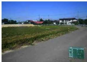
保護盛土着工前 (SE→)
