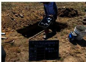
案内板基礎砕石転圧作業状況 (NE→)
