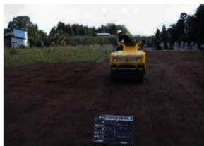
保護盛土(黒土)転圧作業状況 (W→)
