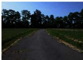
保護盛土〔旧道路部分〕着工前 (N→)
