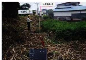
浚渫工No.0+200m地点施工前 (W→)
