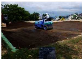
保護盛土(黒土)転圧作業状況 (SE→)
