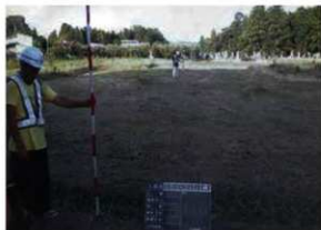
保護盛土着工前 (W→)
