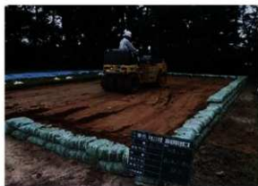
保護盛土 (粘性土) 転圧作業状況 (NW→)
