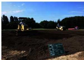
保護盛土(黒土)敷き均し作業状況 (NE→)
