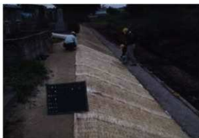
法面工・藁芝設置作業状況 (W→)
