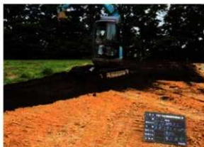
保護盛土(黒土)敷き均し作業状況 (NW→)
