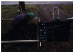
館（曲輪）名称板（検校館）基礎碎石敷き均し作業状況（S→）
