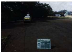
保護盛土（黒土）転圧作業状況（E→）
