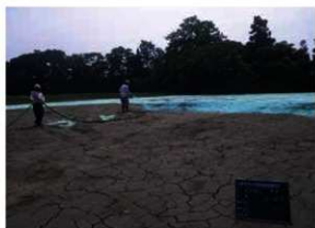
種子散布作業状況 (NW→)
