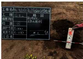
保護盛土(黒土)厚さ確認作業状況④地点 (W→)
