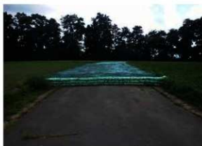
保護盛土〔旧道路部分〕完成 (N→)
