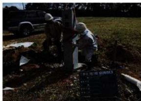
館(曲輪)名称板据え付け作業状況 (N→)
