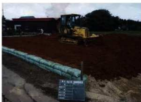
保護盛土 (粘性土) 敷き均し作業状況 (SW→)
