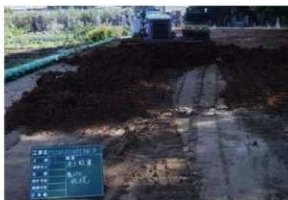
保護盛土(粘性土)敷き均し作業状況 (W→)
