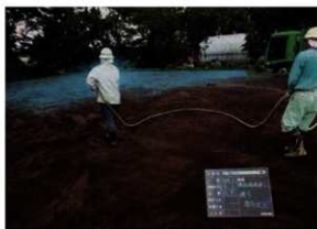
種子散布作業状況 (NE→)
