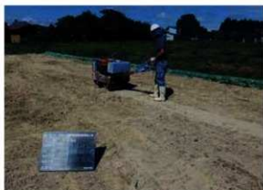
保護盛土(砂)転圧作業状況 (SW→)
