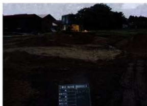
保護盛土 (砂) 敷き均し作業状況 (W→)
