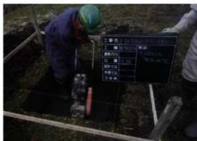
園路表示板（内館）基礎砕石敷き均し作業状況（S→）
