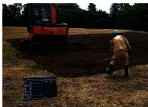
保護盛土(黒土)敷き均し作業状況 (N→)
