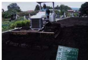
保護盛土(黒土)敷き均し作業状況 (W→)
