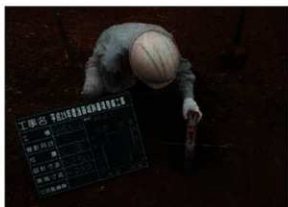
保護盛土(粘性土)厚さ確認作業状況
