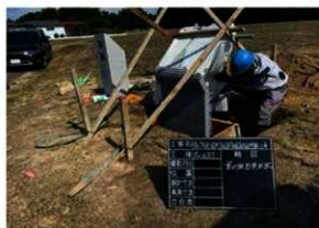
案内板設置作業状況 (NW→)
