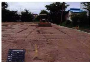
保護盛土(砂)敷き均し作業状況 (S→)
