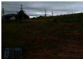
保護盛土着工前 (SW→)
