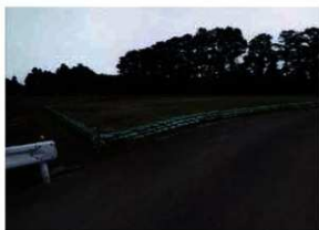
保護盛土完成 (N→)
