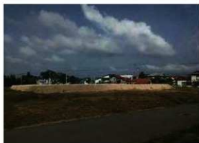
保護盛土着工前2 (ENE→)
