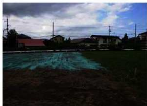
保護盛土完成 (S→)
