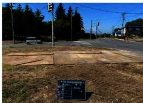
保護盛土敷鉄板設置状況 (E→)
