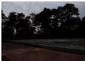
保護盛土完成1 (E→)
