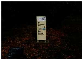
誘導標識（両面）完成（S→）
