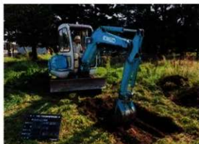
誘導標識（片面2）掘削作業状況（N→）
