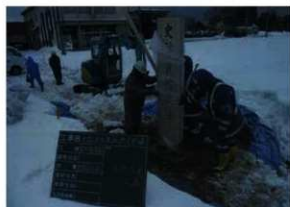
史跡名称板設置作業状況 (WS→)
