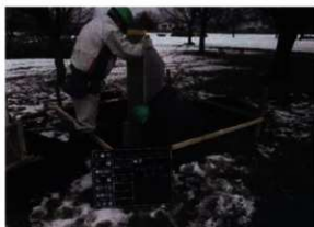
館（曲輪）名称板（東館）設置作業状況（SE→）
