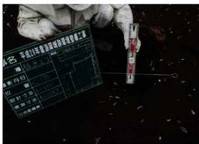
保護盛土（黒土）厚さ確認作業状況
