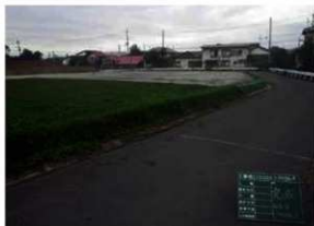
保護盛土完成 (SE→)
