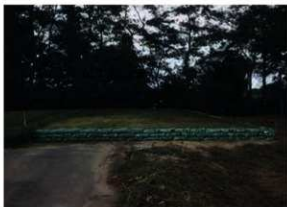
保護盛土完成 (N→)
