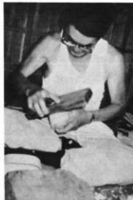
して残った水ですると(写真58)、カナヅチでたいたいてコロシタ底板の周辺部が膨張し、イキルので側板と底板のすきまがなくなり、ピッタリと密着するのである。これが六合村のメンバの大きな特徴になっている打ち込み式の底であり、機械などを使って作った木工品とは大きく違う点である。このため、六合村のメンバは底がぬけず、しっかりしているという評判がある。
