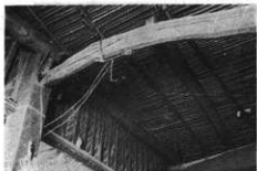
◎ 根井元春 家 スガキ(ハ竹スノコ) 天井 ハリと柱の取り合せ
