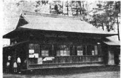
小室の舞台 現在保育園に使用している。間口5間、奥行3間4尺。右の下屋はあとで付けたもの (撮影 関口正己)
