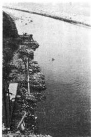
ウシと蛇カゴ (八崎大正橋) これは利根川の護岸 (撮影 今井善一郎)
