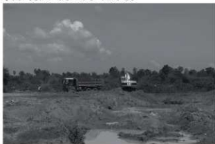
図4 遺跡のすぐ近くで行われている土取り作業の現場
