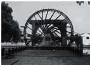
図-9. 新設された水車
