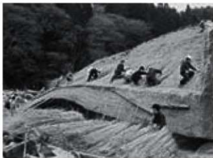
図一10. 残った茅葺き屋根を解体保存するボランティア
