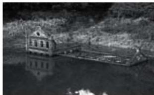
図-7. 旧曾木発電所(2007年12月撮影)
