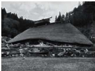
図一9. 津波で全壊した尾形家住宅（氣仙沼市）
