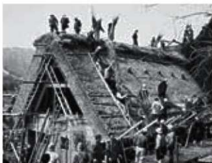
図-6. 保護資産・旧松井家の屋根葺き（岐阜県白川村）
