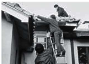
図一八、地元建築士らによる応急修復（旧モーガン邸）
