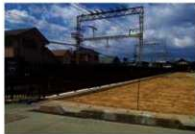
鉄道沿線のフェンスを新調し芝生を植え、駅周辺の美化・緑化も進めています。
