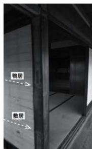
③ 式台玄関戸袋内側の壁の痕跡 (南面)。②に対となる曲跡
