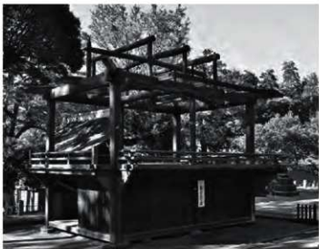
解体中の前身神楽殿（2019年11月）
