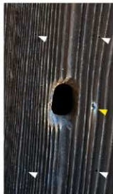
写真3 鋸金物 D の銅製釘と釘 穴<春日社>
