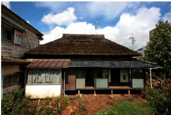
外観 正面（南東から）
