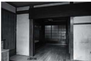
玄関にある当初の土間出入口には差鴨居が残る。 内側に上げ戸の取り付けいた痕跡
