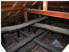
小屋組下方では、既存部材をもとの組み合わせのまま用いる。
