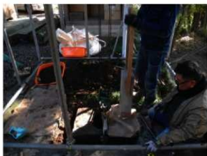
6 根石の据え直しは、柱の傾きが左に崩うように外側に40ミリ移動し、木の根により持ち上げられていた分低くした。地面をすきとり、タコでそっと叩きながら調整。
