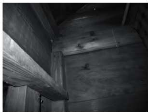
内部の隅を見上げる。隅は丸柱に加工されていない。
