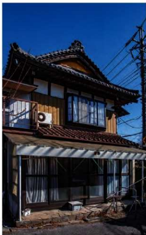
南面の台所の土間には、3台のカマドがあった。 現在は拡張され、日当たりのよいサンルームとなっている。
