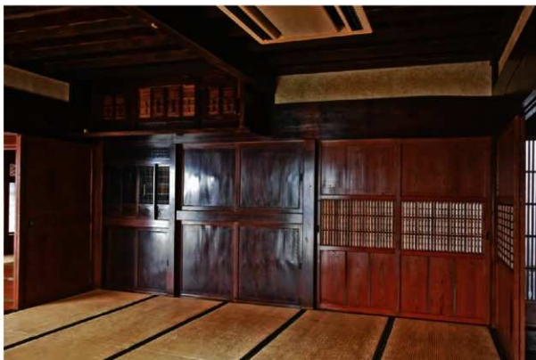
座敷 西壁を見る。
