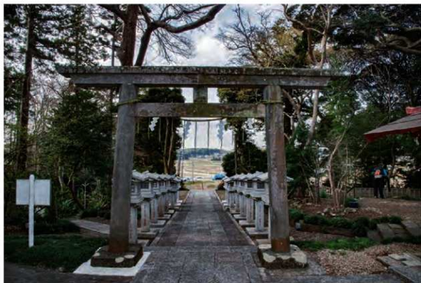
修理後の鳥居 背面
