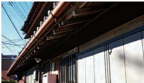
茨城より入手した、下屋全長に及ぶ一材からなる杉丸次の桁
