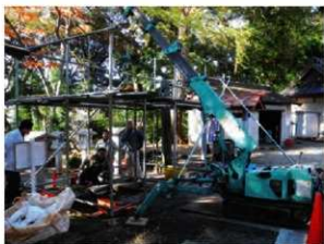
5 クレーンで根石を吊り上げて、この下の地面の状況を確認。
