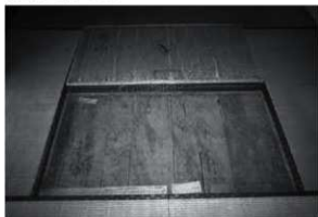
奥の間 畳の下の荒床(あらゆか)の表面には手挽き鋸による加工痕があり、常に畳が敷かれていたことがわかる。
