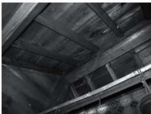
屋根裏見上げ
