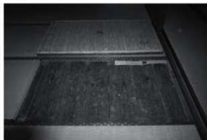
中の間 床板には鉤がかけられ、色合いから畳を敷かずに使用されたことがわかる。
