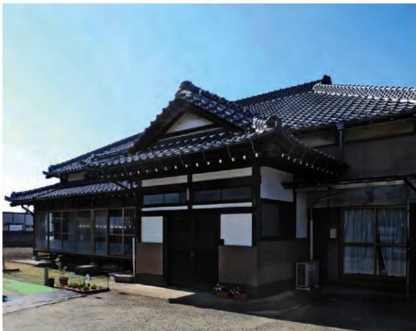
正面 玄関 北東から見る。
