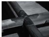
縁高欄架木(ほこぎ)交差部の 釘金物
