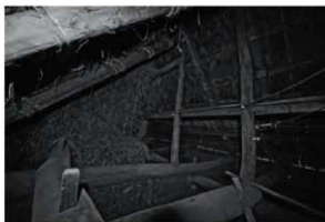
写真3 小屋組 西から東を見る
