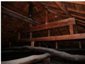
新材で瓦葺のための小屋組を設けた。棟木を支える部材には 「棟束」と記す。煤けた棟束は当初材を再利用したものの。
