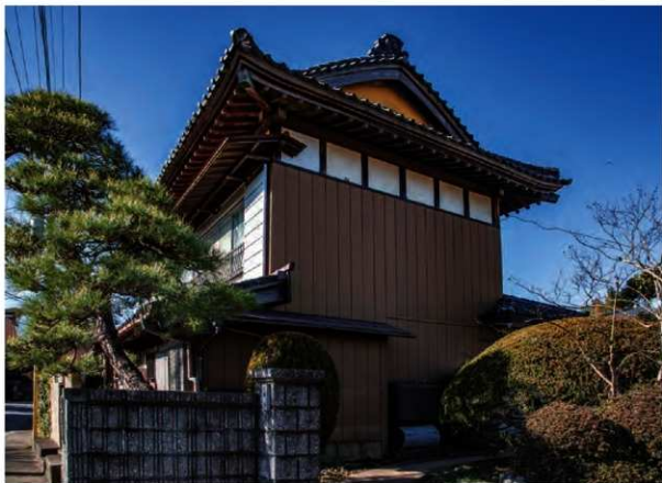
北東から見る 隅に反りのある重厚な軒廻りと入母屋造の屋根。 北面の小さな庇がかつての出入口の位置を示す。 この向かって右側に、平屋の女中部屋が取り付い ていた。
