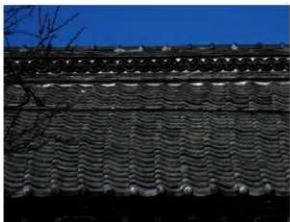
棧瓦葺の屋根 大棟は丸瓦を輪違いに積み、模様をつくる。
