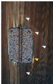
写真2 鋸金物 A の痕跡と銅製釘、 釘穴<春日社>
