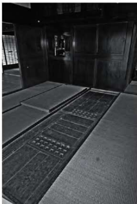
座敷 畳の下に発見された囲炉裏は、養蚕用に開発された効率の良い火炉の形式
