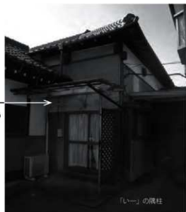
台所北東角。ペンキ塗された土間の差鴨居が室内 (左図) から続く。隅柱が番付の起点となる「いー」
