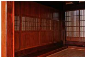
土間一座敷境の板戸 土間から見る。
