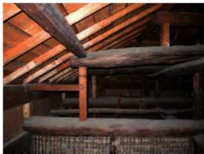
新設された桁を繋ぐ部材や野垂木・野地板が新しくされた。 土壁の取り付く梁を含む下方の梁組は再利用された。
