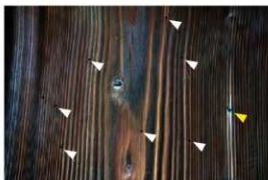
写真4 鋳金物Bの銅製釘と釘穴<春日社>
