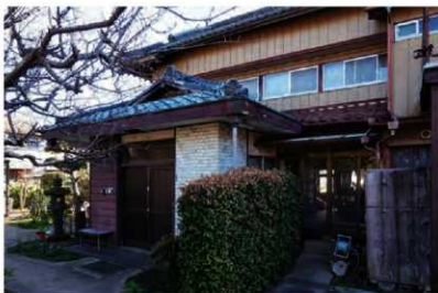
背面に新設された玄関。住宅への改造時に正面玄関は閉鎖され、台所が造られた。
