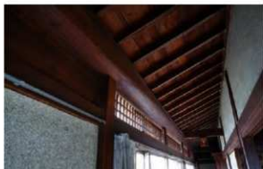
南縁 縁桁は長尺材の杉丸太。化粧軒裏、欄間には格子建具に磨りガラス。
