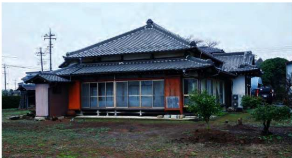
側面 南から見る。
