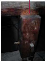
上端を1尺切断された第2大黒柱。 各面に使用されていない貫穴がある。
