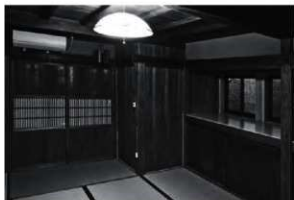
勝手 南壁より納戸に入る。西壁では押入を改造して地袋とする。
