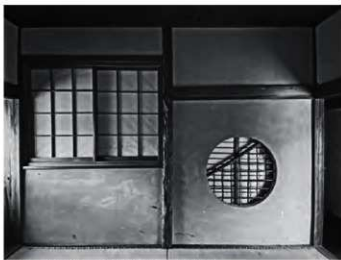
居室3 北壁全景 棚と丸窓から構成される。 棚は撤去され、階段室上方に開く障子戸が建て込まれている。
