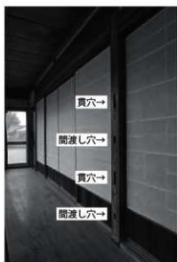
④ 式台玄関袖壁の土壁が取り付けいた痕跡
