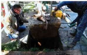
2 根石を吊り上げる。
