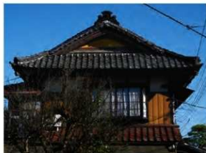
南妻 入母屋造の屋根の破風板下端に曲線が施され、柔らかな印象となる。妻壁は黄色の色壁。
