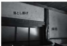
居室3 北壁には棚廻りの造作が残る。 杉絞り丸太の「床柱」とモミジの落とし掛け。 腰高の棚が階段の上方に突き出していた。
