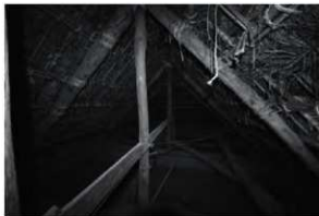
写真4 小屋組 東から西を見る
