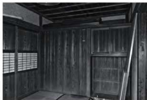
納戸 座敷の仏壇と押入の裏側が見える。南壁(画面右)から奥の間に入りりできるように改造された。
