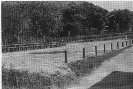
図版35 瓦窯跡緑化修景工事
