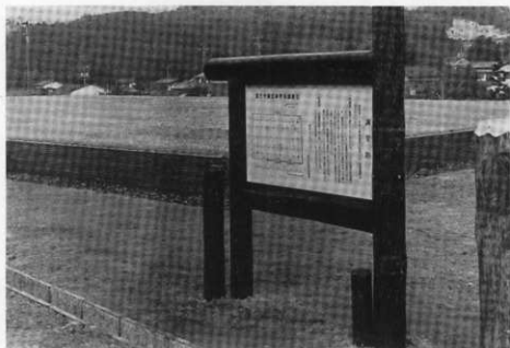
図版34 説明板設置工事
