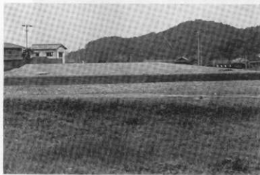
図版32 講堂跡基壇復原工事 （東より）
