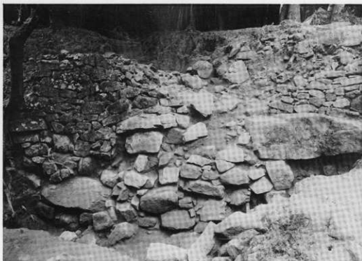
第 8 圖 大石垣の積石状態
