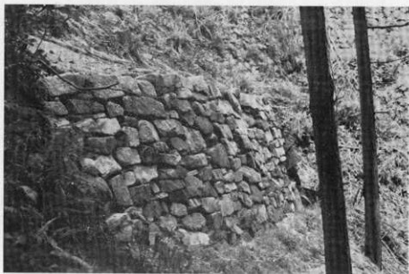
圖版15 石積復原工事
