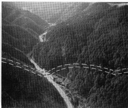
図版 5 百間石垣遠景から(北から)
