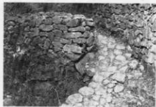
図版18 大石垣遺構復原保全工事
