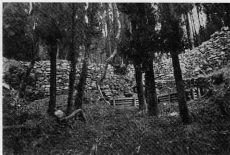
図版19 大石垣遺構復原保全工事 (下流側より正面をみる)
