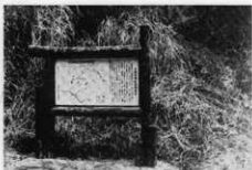
圖版39 主城原導入口說明板設置工事
