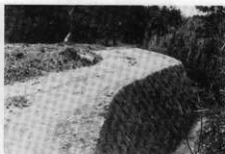
圖版40 主城原礎石建物跡基礎保全工事
