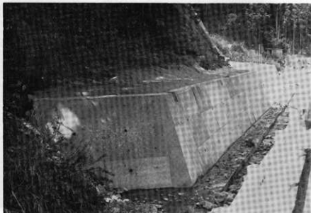
図版2 (II. 百間石垣(保全工事))
