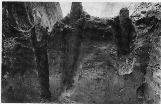
図版8 積土中の杭とシガラミ（南から）
