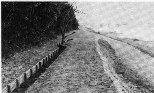
図版14 国分側土堤保全修景工事
