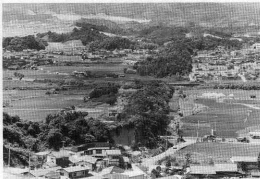
図版2 水城大堤全景（昭和48年自動車道建設前）
