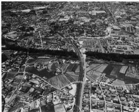
図版16 水城跡 上方は大野城市（福岡県） 下方は太宰府町側（南より）
