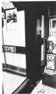
〔写真—31〕阿久沢一郎家の大黒柱、この大黒柱は間仕切の中心線よりタイドコ側に逃げて据えられている。これを大黒柱の逃げがあるといい、新しい大黒柱の特徴である。
