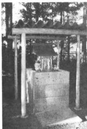
新築した屋敷神 (柏倉) (関口正巳撮影)
