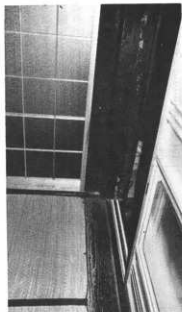
〔写真—30〕松村忠次郎家の大黒柱、大黒柱は間仕切の中心線上に据えられている（古い遺構の特徴である）。
