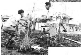
杭打ちの儀（棟梁が行う）
