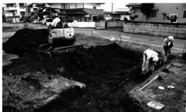
重機によるⅢ区表土剥ぎ状況
