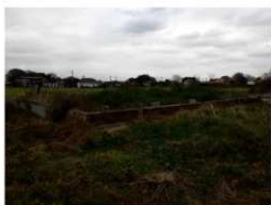
③ 史跡内残留物 (建物基礎(1))
