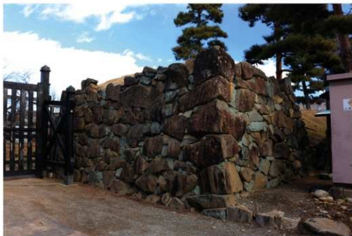
図版 4 竣工後（南西から）
