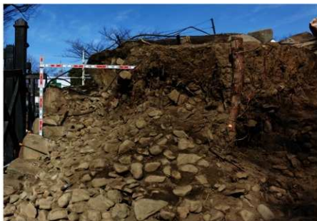
図版 11 盛土部（南から）
