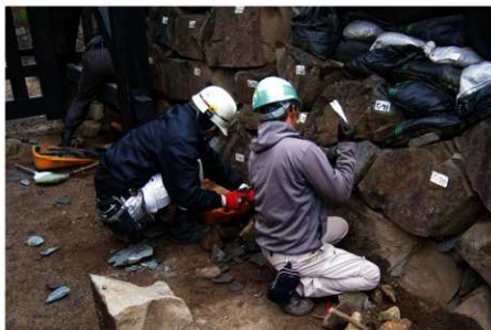
図版 12 間詰補足工事 解体しない石垣の範囲には間詰石の補充を行った。 新たな間詰石は見えない部分に着色を行い、新補 石材であることがわかるようにした。
