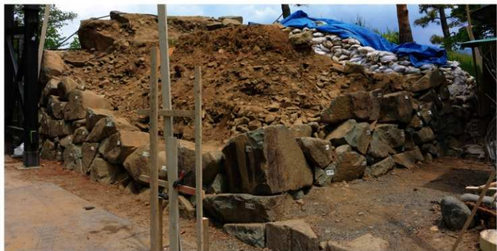
図版 13 解体完了 (南西から)
