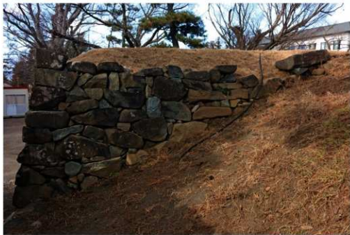
図版 5 竣工後（東から）
