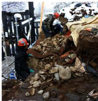
図版8 解体中（築石解体）
