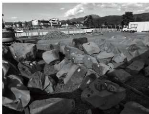
5. 解体築石仮置場 01
