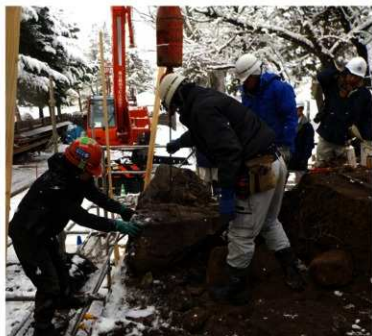
図版7 解体中（築石解体）
