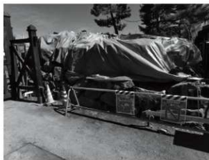
3. 本丸北外堀南面石垣 C区間 石垣状況
