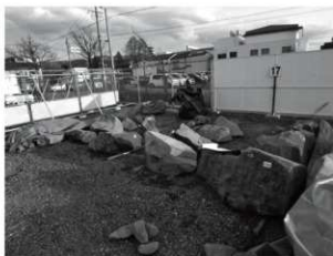
6. 解体築石仮置場 02
