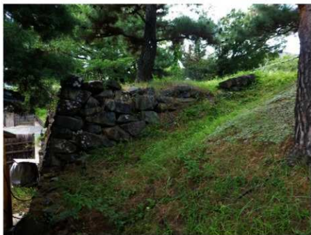
図版 2 着手前 (東から)
