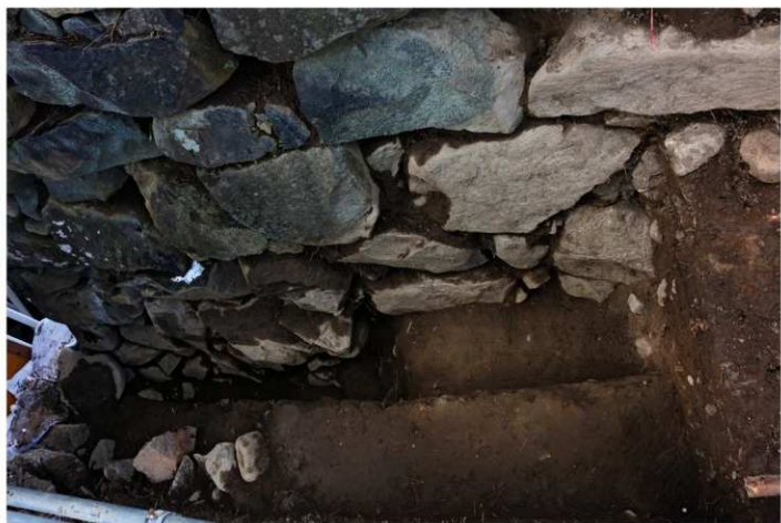
図版 20 H28 年度発掘② 石垣食い違ひ 石垣東面埋没部の築石に、積み直しの跡と考えられる食い違ひが生じている部分が確認された。
