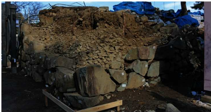
図版 10 盛土部（南西から）解体に伴い、石垣内部に盛土が確認された。
