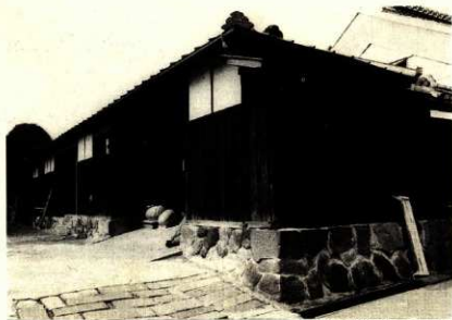
長谷川陸治家の長屋門
