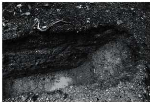
第 1 砲座 東壁面 西より
