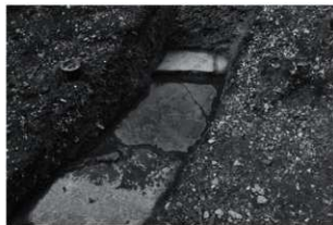
第 3 砲座コルタルン塗布範囲 南より
