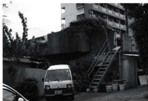
第50図 国次陣地 第3分隊砲台 撮影 伊藤厚史
