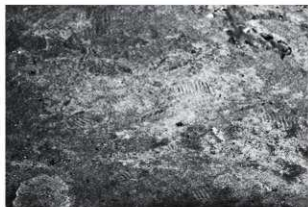
第 5 砲座 コンクリート表面に残っていた足跡 南より
