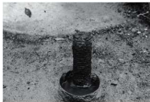
第 1 砲座固定用ボルト検出状況 東より
