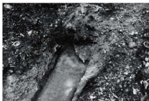
第 3 砲座退避壕 北より
