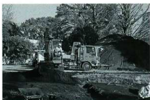
写真2 一次掘削風景(西より)
