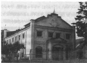
岩室発電所建屋 - 写真75
