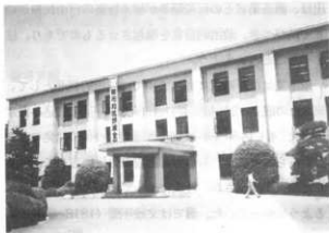
本館正面-写真85
