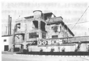
電解工場外観 - 写84真
