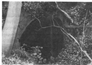
旧坑道入口 - 写真80
