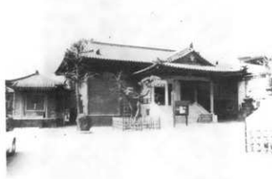
橋林寺旧本堂正面 - 写真138
