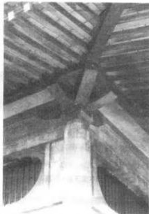
柱の状況 - 写真139
