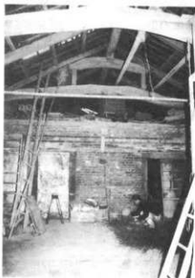
レンガ造室(△口) - 写真86
