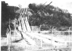
上久屋発電所水圧鉄管 - 写真76
