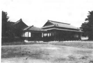
建物南側-写真125
