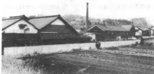
倉とレンガ煙突-写真89
