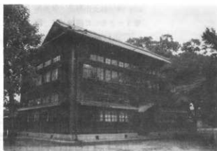
本社事務棟 - 写真33
