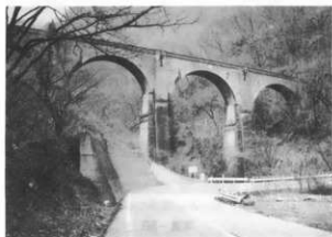
旧碓氷第三号橋梁—写真60
