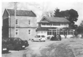
2階煉瓦倉庫と旧事務棟-写真28
