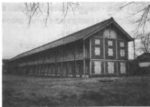
西蔵倉庫 - 写真17
