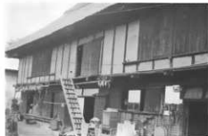
民家（中山，平形政英家）出し梁になっ ている部分には下からははこで上るよう になっている。
