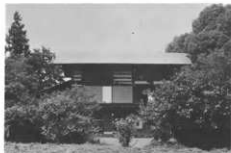
三階建の養蚕農家（川戸，中沢茂雄家） 約80年前に新宅に出た時、蚕を飼うため 三階建を建築した。
