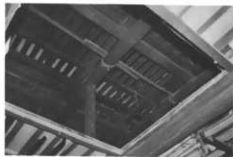
民家構造（島村）二階より天井裏の部屋（3階）を眺む。
