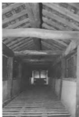
民家構造（島村） 棟上の高檜の内部。 床は通風のよいよ うスノコ状になっ ている。
