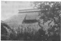
煙出し（横室）昔の家屋は通風の設備がなかった。これは紺周郎銅の頃の煙出し。
