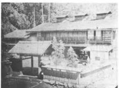
〔写真一七〕島崎正治家（西上秋間下り貝） （明治38年に撮影したもので、板葺の 様子がよくわかる）
