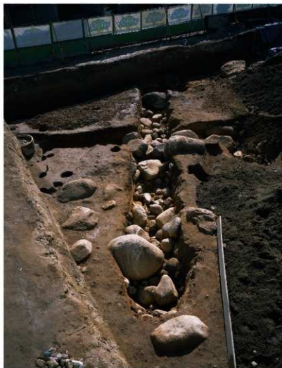
第38图 下層土石流検出状況
