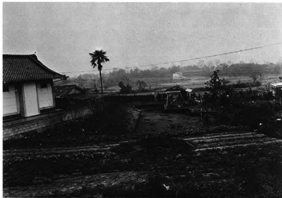
1 A区遺構全景
