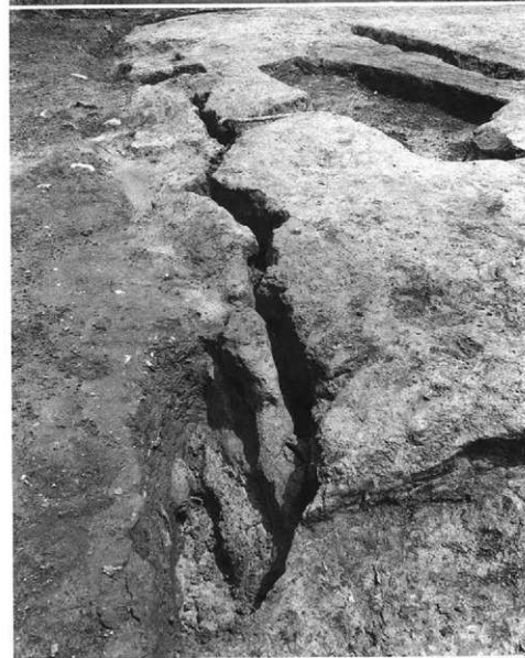
3. 同上 地割れ跡（南から）
