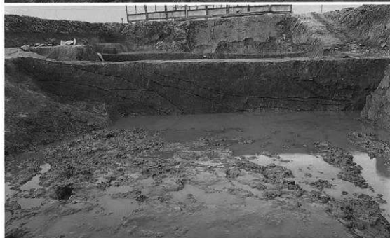
2. 1区谷南側ベルト 土層 (南から)
