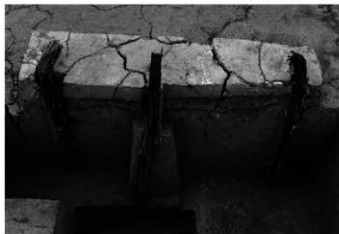
杭12~14 断面 (142~142') (東から)
