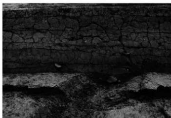
SD853 断面 (117-117) ② (南から)
