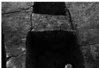
SD646 断面 (106-106) (西から)
