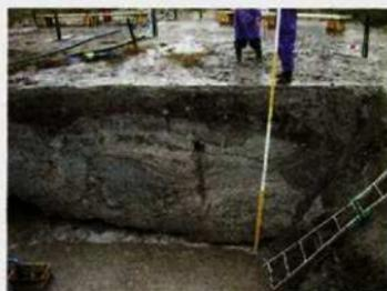
写真2 トレンチ6 河床堆積層の液状化
