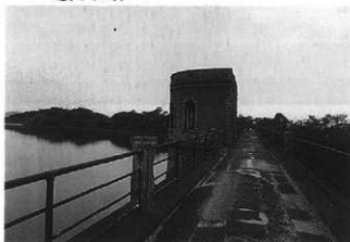
▲ 取水塔 (1992年岡田撮影)
