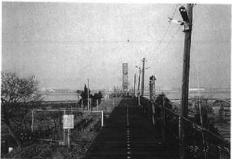
▲ 旧奥後若津駅から橋梁を望む (同上)
