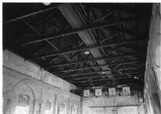
▲ ポンプ室屋根内部（1992年開田撮影）
