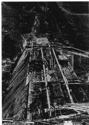
河内ダム工事（昭和28年撮影）八幡製鐵所土木史による。この写真は現在のバス道路側から撮影した様子。堰堤工事は7ブロックに分けて施工された。当時は機械力が貧乏だったので、人力作業が主であり、この工事にかかった人手は延べ90万人と推定されている。いろいろの資料から推測しても、この工事で殉職した人はいないとされている。実に稀有のすばらしいことである。写真でもわかるとおり、堰堤は岩盤を深くまで掘られていて、工法からみても、水圧にはどくどくしない構造になっている。
