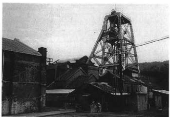
▲ 二坑立坑機 (1991年撮影)
