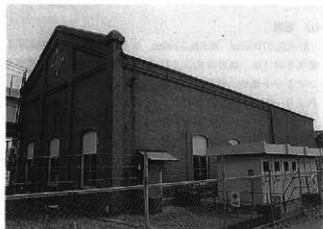
▲ ポンプ室（1992年開田撮影）
