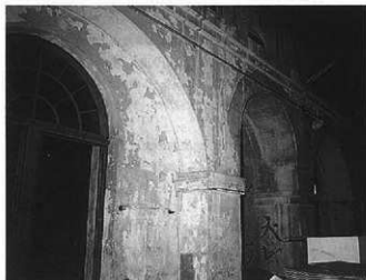
▲ 建物内部 (1992年、平島撮影)
