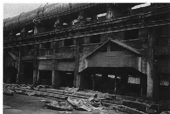
▲ 工場全景 (1992年、平島撮影)
