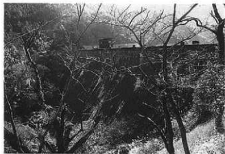
▲ 河内貯水池堰塔 (1993年撮影)
