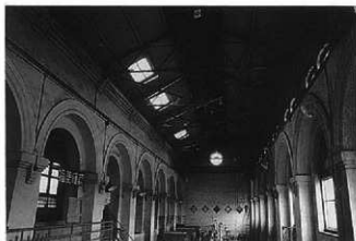
▲ ポンプ室内部（1992年開田撮影）
