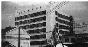
工場全景(1938年、平島撮影)
