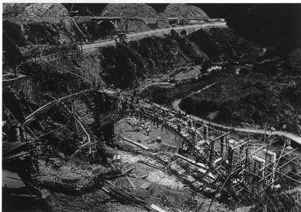
◀ 河内水橋工事（昭和十一年撮影）八幡製鐵所土木史による
