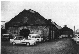
▲ 工場全景（1992年、平島撮影）
