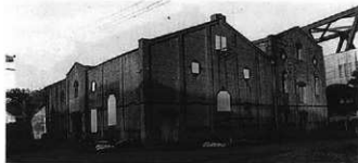
▲ 旧製鉄場 (現在は綿材置場、1992年撮影)
