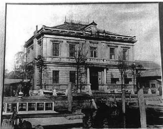
▲ 改修前の石炭会館(撮影年不詳、若松石炭会館所蔵)
