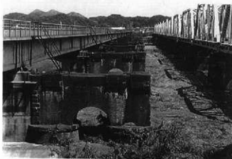
▲ 河川敷内の橋脚 (1992年撮影)
