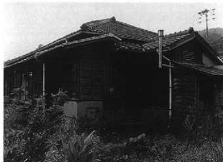
▲ 同上社宅の玄関側の状態 (1992年撮影)
