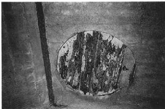
▲ 天井の扇風機取付跡 (1992年、東定・深町撮影)
