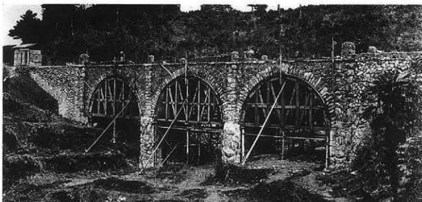
◀ 中河内橋工事（昭和十一年撮影）八幡製鐵所土木史による 現在の河内町の下にある橋
