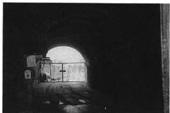
▲ 二坑坑口 (1991年撮影)
