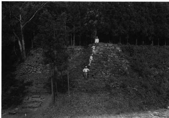
1. 御別館勝手門石垣と北口筋階段（北西から）
