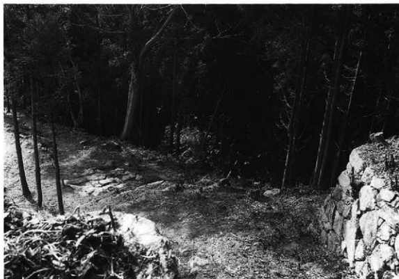
2. 御別館搦手門の西側張出部石垣から北口筋階段・通路を望む (南東から)
