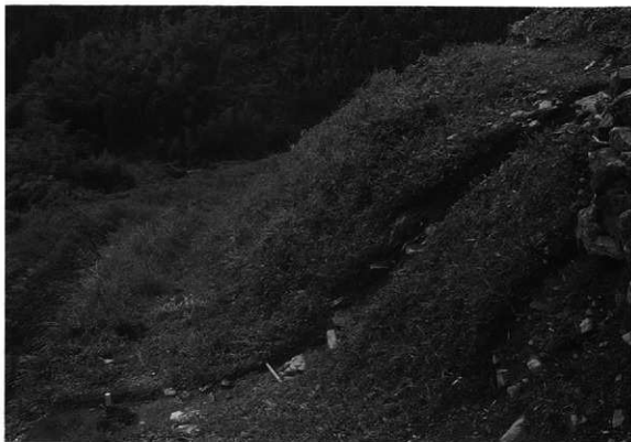
2. 南口筋通路 [No.17南北トレンチ] から犬鳴川を望む (東から)
