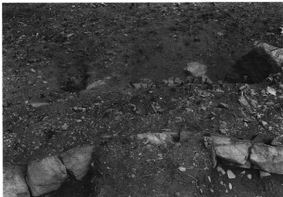
1. 南口筋石垣〔P151 - P161〕(北から)
