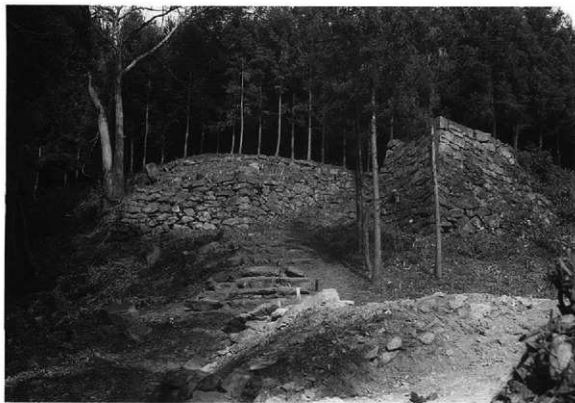
2. 同 【同除去後】(北西から)
