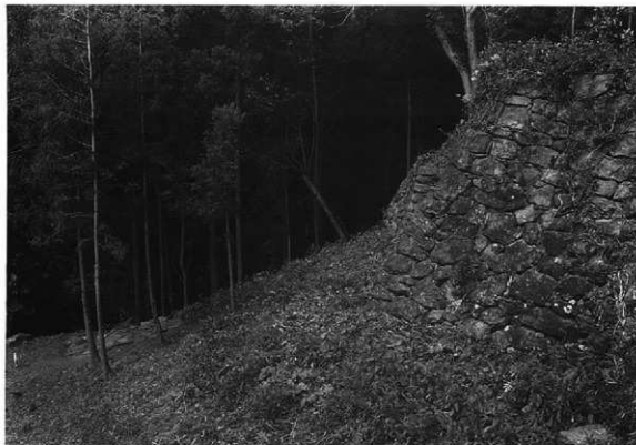
1. 御別館揃手門石垣【繁茂する葛・竹・草類除去前】(西から)
