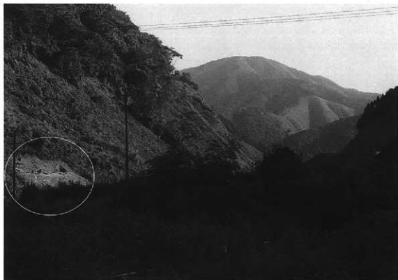
(1)第3地点 遠景 (○の部分) 西側から
